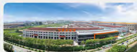
震雄深圳工业园——生产总部
