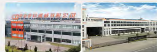
震雄顺德生产基地
