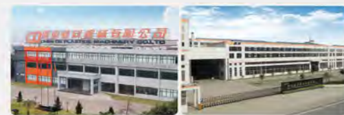
震雄顺德生产基地
