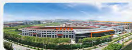
震雄深圳工业园——生产总部
