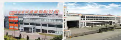
震雄顺德生产基地
