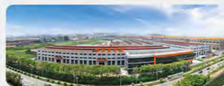
震雄深圳工业园——生产总部
