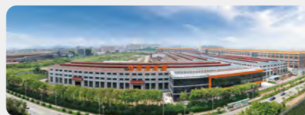
震雄深圳工业园——生产总部
