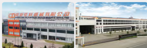
震雄顺德生产基地
